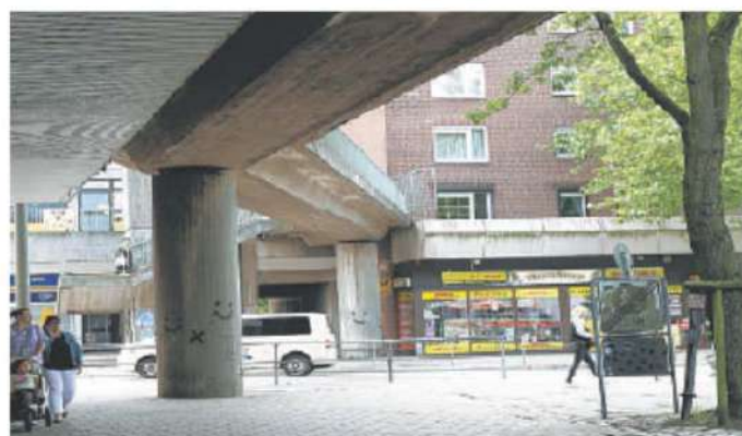
Die Brücke über die Billstedter Hauptstraße soll abgerissen werden
