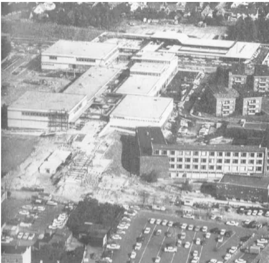
Der im Bau befindliche 1. Bauabschnitt des Billstedt-Centers mit heutigem Kundenzentrum und U-Haltestelle am oberen Bildrand (aus: Billstedt aus der Luft; Geschichtswerkstatt Billstedt)
