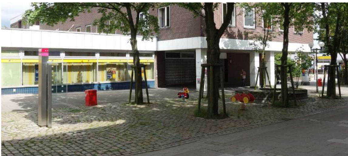
Fußgängerzone Möllner Landstraße mit Einbauten
