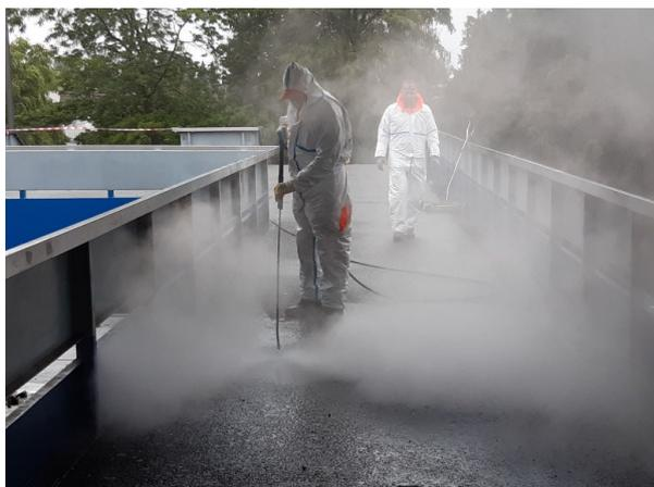
Abb. 21: Grundreinigung Fußgängerbrücke (Foto © plankontor)
